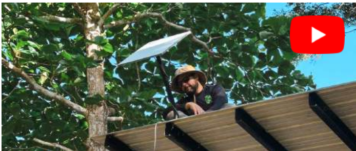
Instalación / Installation of Starlink internet
